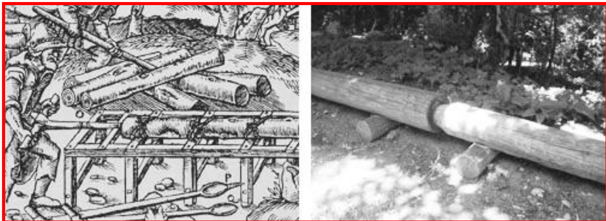
Bournelier perçant un tuyau de saumoduc et reconstitution du saumoduc à Bex http://www.sentierdusel.ch/
